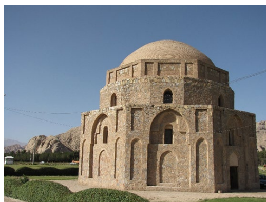
شکل ۱. نمای جنوب غربی گنبد جبلیه
